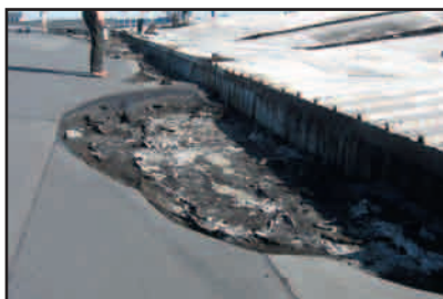
fot.1 Całkowicie zniszczony dach po pożarze budynku.
